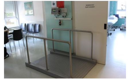
Bodeneben eingebaute Wägebrücke
